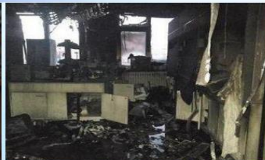
爆炸后的实验室现场
