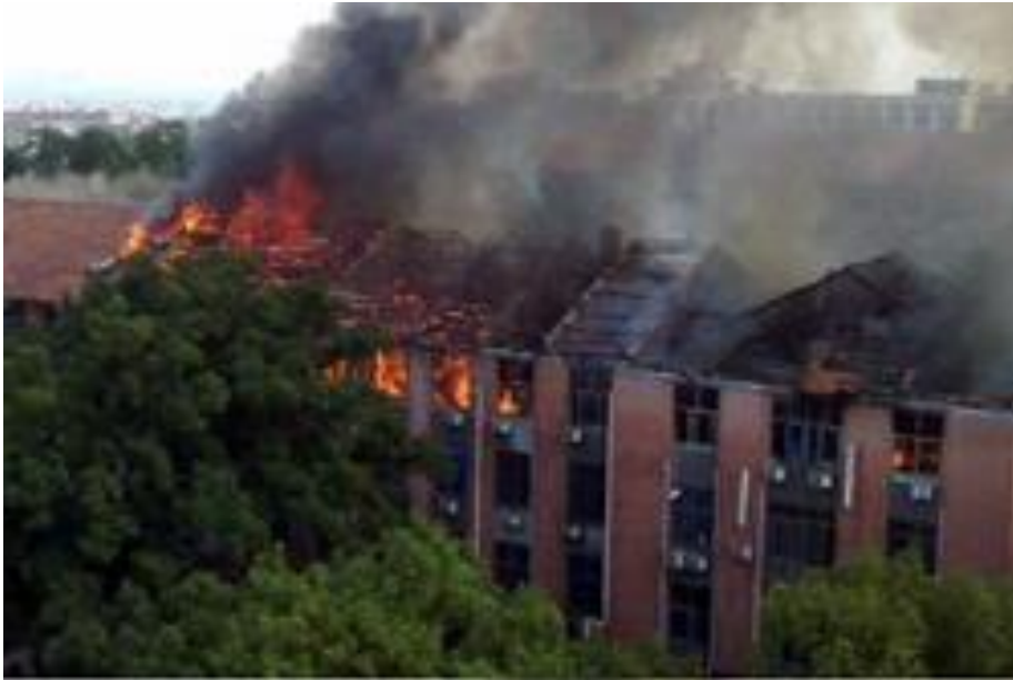
2011年10月10日中午，中南大学化学 化工学院理学楼发生火灾
